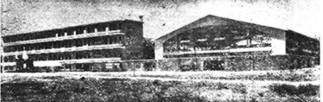
【写真】本会館となる五城目第一中学校の全容
