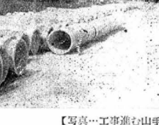
【写真...工事進む山手線】
