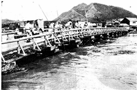
危険となった五城目橋を守る消防署員
