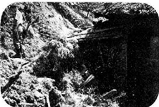
山くずれで危険にさらされた民家(寺庭)
