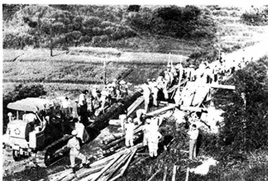
流失した県道新築橋の板橋は町長陣島指揮で18日完成した
