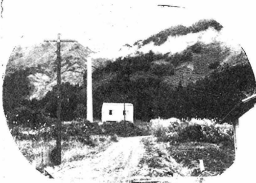
(ごみ焼却場完成し11月から操業、1日焼却能力7・5トン)
