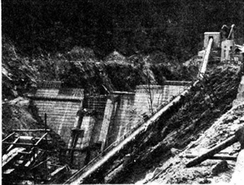
(写真) 昼夜兼行で工事をすすめる萩形ダム……10月18日撮影
