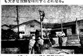
(急ピッチに進む架設工事)
