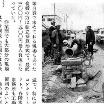
等自費で求めておる現場もあつた。食費の方は独立採算形式で、最低三〇〇円～五〇〇円当人負担となつていた。 作業面でも大部分の現場は、世話役(現場では係長)が、本町の人か、付近町村出身の人達で、一緒に働らく人もほとんどが友人か知人といつた具合で、県内の土木現場と変らないムードなので異郷の地と言う感じではなかつた。 ただ私の行った二月初旬頃は、毎日晴天つづきで休日がとれない現場、又賃金の手取りがない現場、又反面残業あり、請負ありで、来年々では是非働きたい現場等様々であった。特に本町から土木の三業者(南秋土
