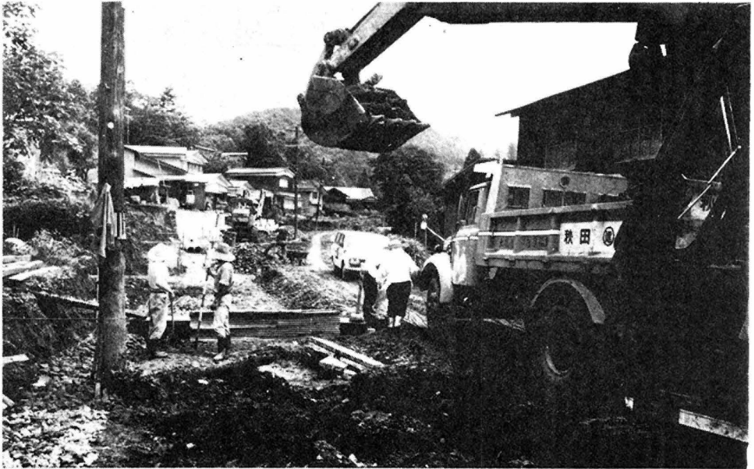
<落合部落国道現場>
