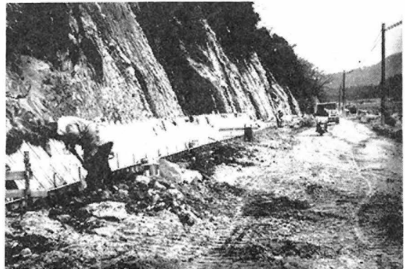
国道285号線大手～落合間改修
