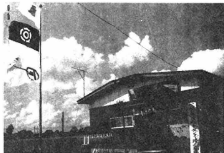
下樋口に生活総合センター竣工(9.30)
