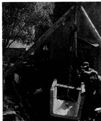
大川下水路整備工事 延長145m=工事費137万円=竣工7月末
