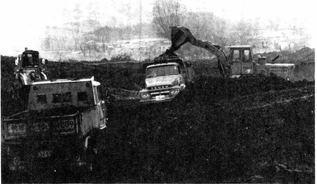
写真は河川改修掘削現場
