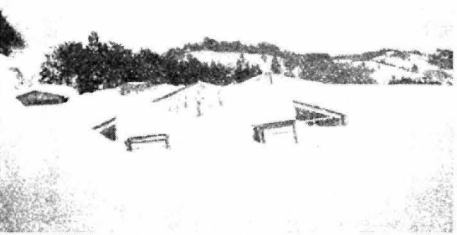
岡本ビルハウス倒壊
