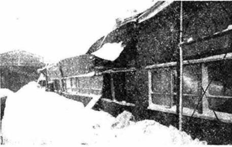
1月26日 田町工場屋根陥没
