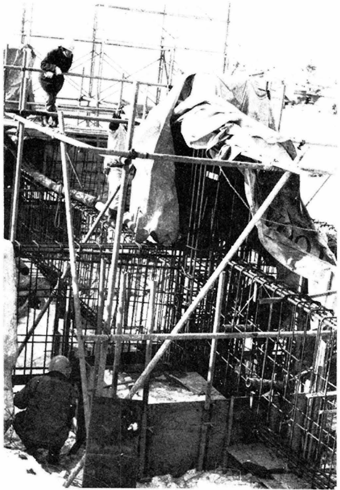
基礎コンクリートの打込みをはじめた開発センター
