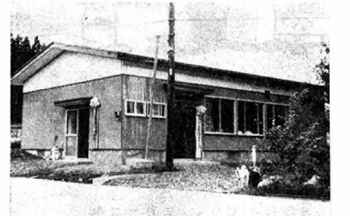
完成した蓬内台部落生活総合センター
