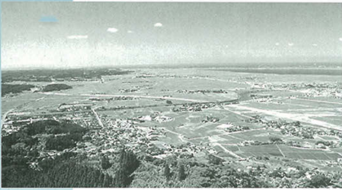
森山からは、未来へつながる高速道路の工事のようすが見渡すことができます
