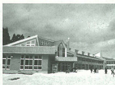
1月25日、馬場目小学校新校舎・体育館が完成
