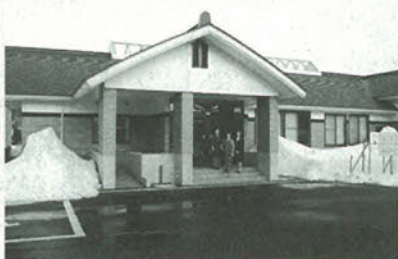
3月17日、老朽化した馬川地区公民館を改築し、馬川交流センターが完成
