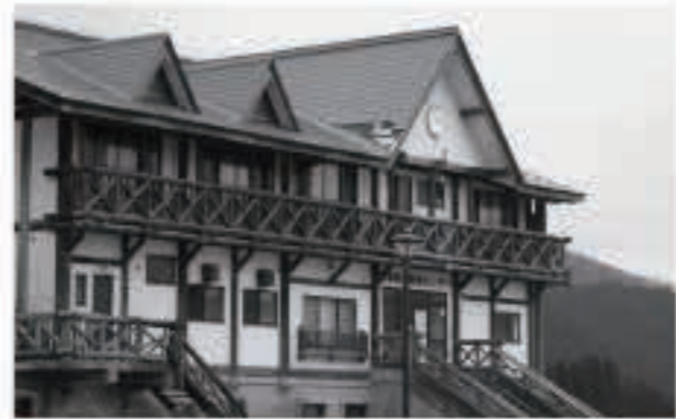
休館中の恋地山荘を解体
