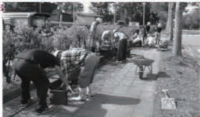
子どもたちが安全に登校できるようにと思いを込め、五城目建設業協会の皆さんが町民センター前の歩道を直してくれました
