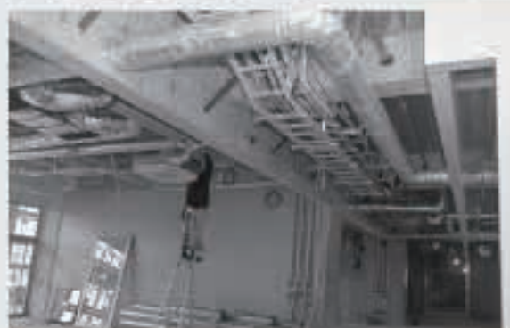
1階の様子です。空調設備、電気設備工事が進んでいます。
