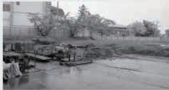
学童施設用地です。この後、測量し、基礎工事が始まります。
