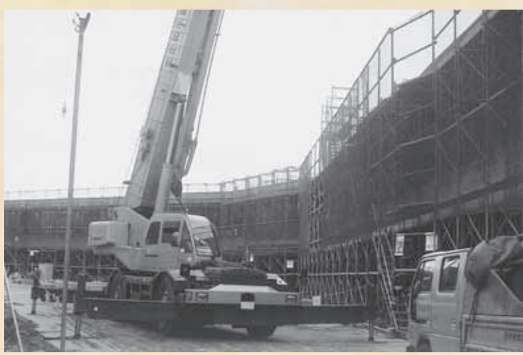
五一中建設工事
