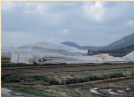
暴風被害でハウス崩壊
