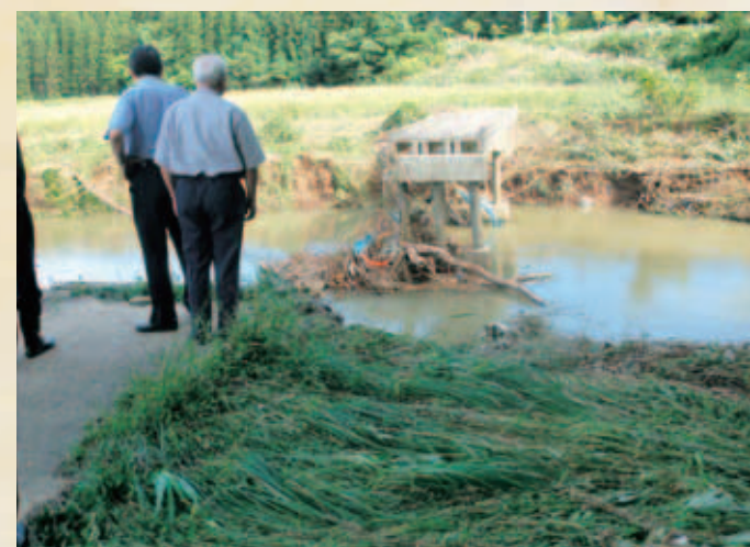
下山内の豪雨被害
