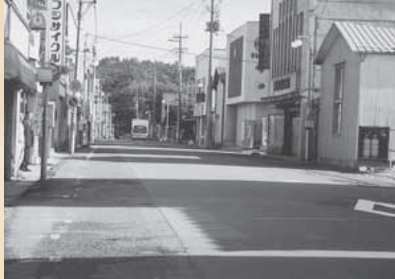
側溝改良される下タ町通り
