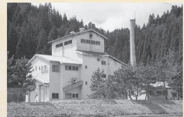
解体工事されるゴミ焼却場
