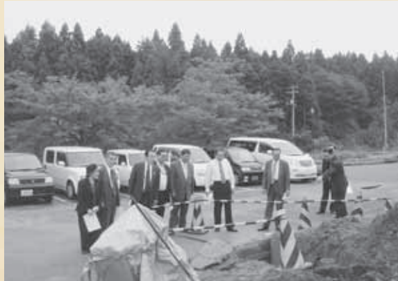
漏水個所の調査（森山荘）
