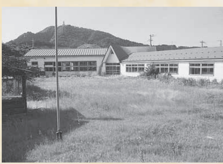
解体前の旧五城目幼稚園
