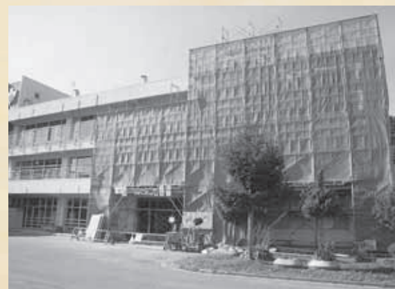
五小耐震工事
