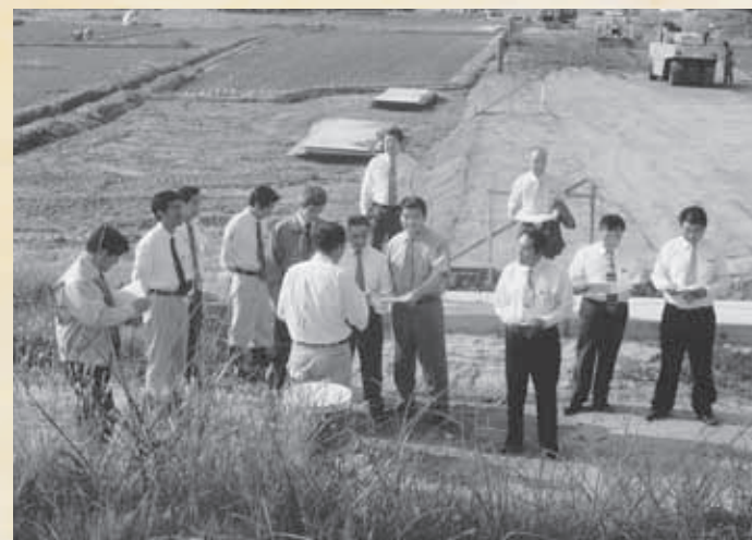
下山内小倉線改良工事を視察
