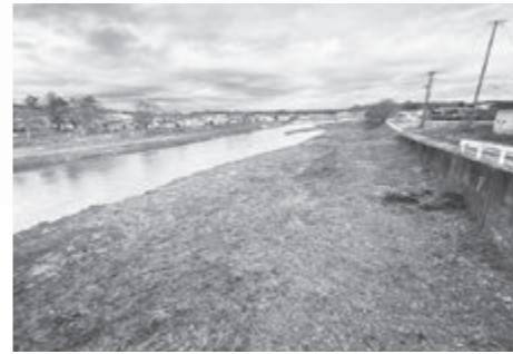
取り除きの必要な堆積土砂
