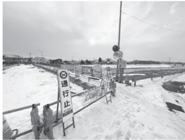
防災会議での災害検証が重要（五城目橋）
