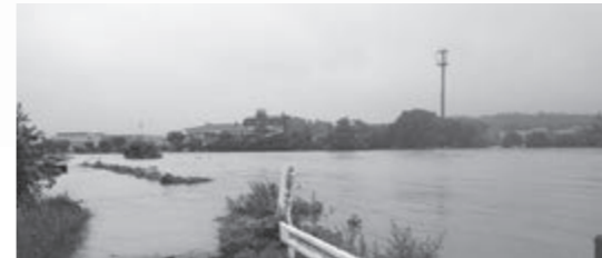
検証がなければ改善はない (五城目橋から上流を望む)
