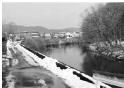
子どもに危険な川沿い、堀は60cmもない 五中敷地への通学は危険では
