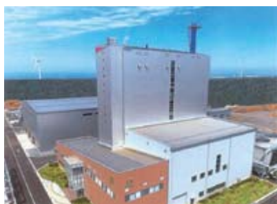
バイオマス発電所
