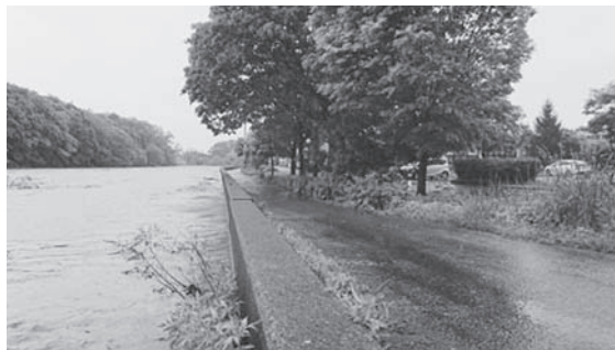
堤防ギリギリまで水位が上がった馬場目川
