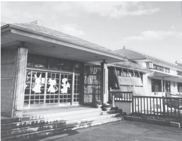
耐震補強工事が待たれる大川分園
