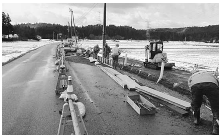
五城目外環状線の復旧工事
