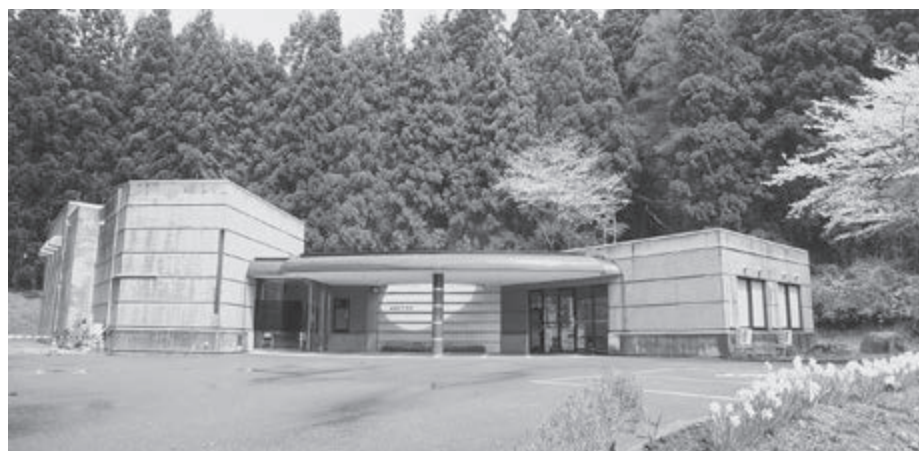
改修される火葬場の実施設計費用計上
