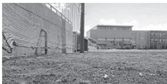
地面から浮き、針金がむき出しで非常に危険なバックネットは早急な修繕が必要だ
