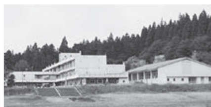
安全対策に万全を期した工事が求められる
