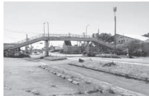
高齢者に優しくない歩道橋
