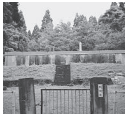
老朽化が進む配水池
