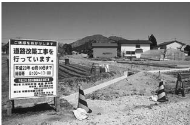
工事が遅れている未舗装道路
