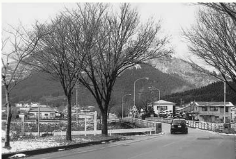
交通量の多い西野橋
