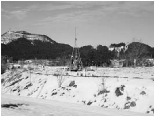
建設用地のボーリング調査
