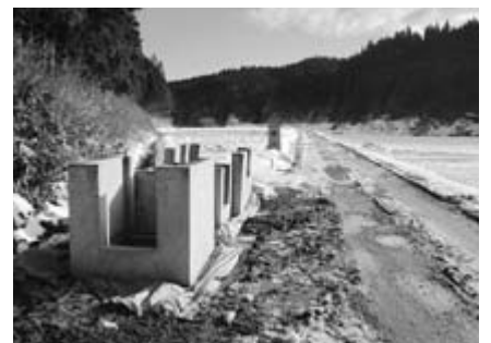
小川口の工事予定地
