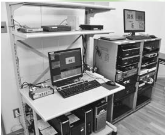
サーバーなどの機材
