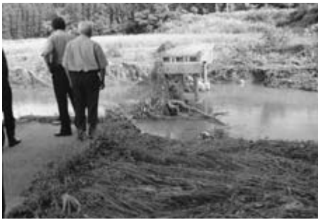
下山内の豪雨被害
