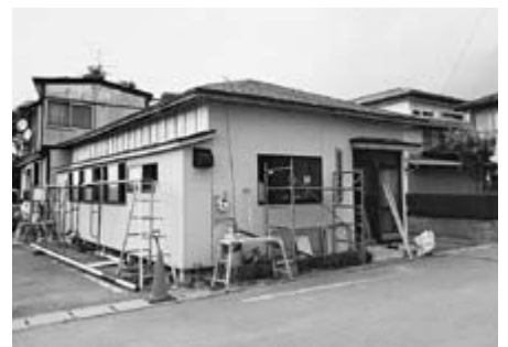
改修中の集会所
