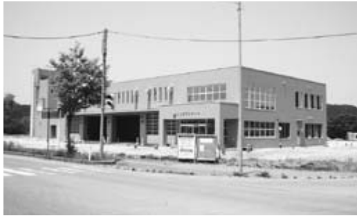
完成した消防庁舎
