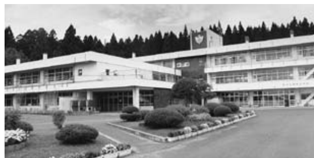
改築が望まれる五城目小学校
