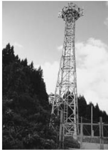
薬師山に建つ無線中継塔
