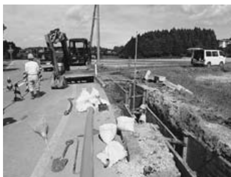
広ヶ野下水道の工事
