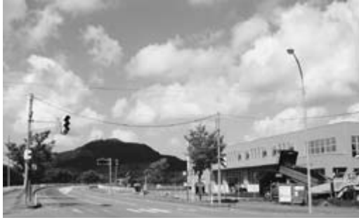
外構工事中の消防庁舎
