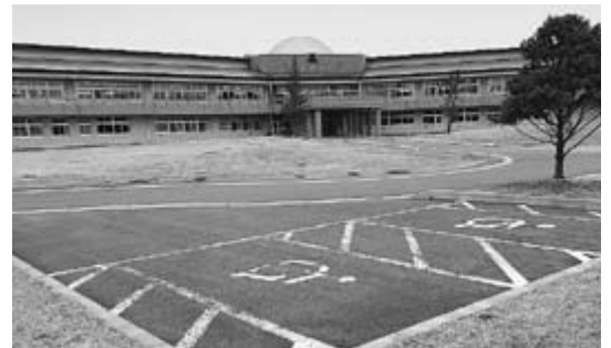
遠すぎる障害者用駐車場(五一中)
