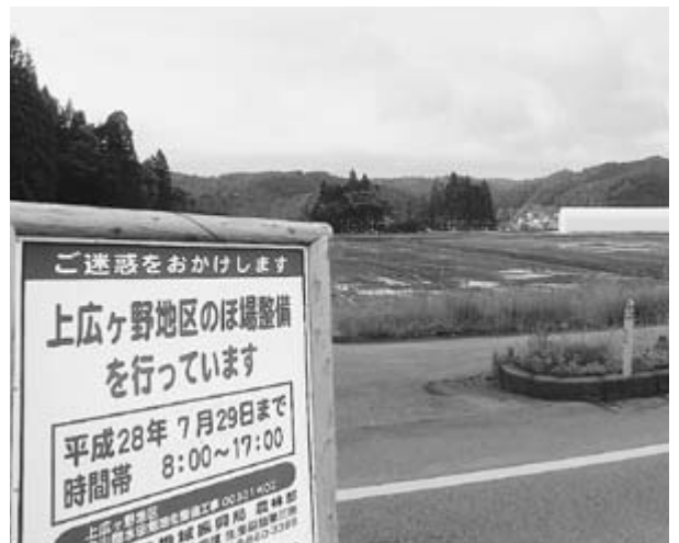
工事中の水田畑地化事業
