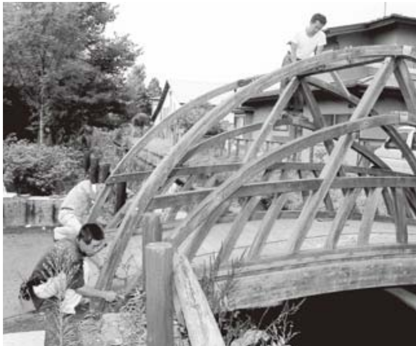
ぐらついた木橋もしっかり固定し、安全に渡れるようになりました。（戸村堰緑道）
