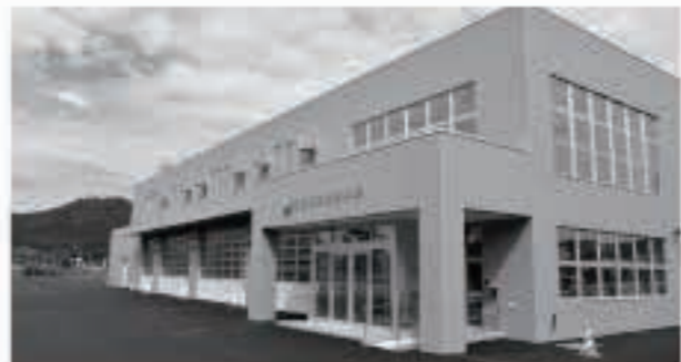
下山内に完成した新消防庁舎
