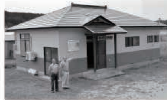
あきた未来づくりプロジェクト事業により、屋根や外壁を改修した寺庭公民館
