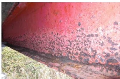
「防食機能が劣化した状態」
