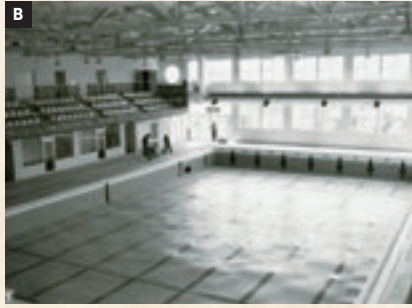
屋内温水プールが竣工
