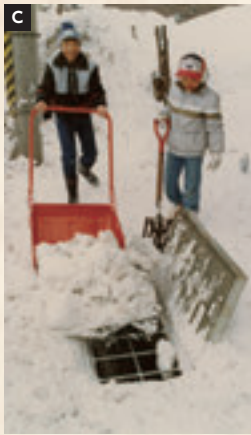
C 上町通りの流雪溝が完成
