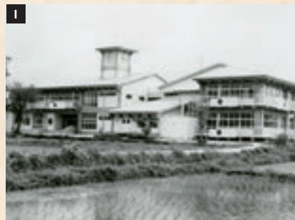
I 大川小学校校舎改築工事が竣工
