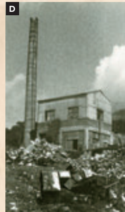
町塵芥処理場 が竣工
