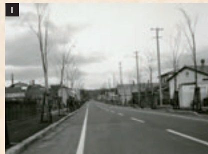
町道山手線が開通
