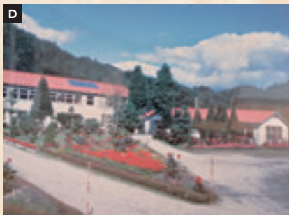
富津内中学校校舎が竣工
