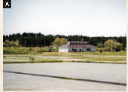
上山内地区農業集落排水施設を供用開始
