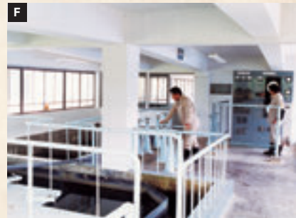
町上水道が通水
