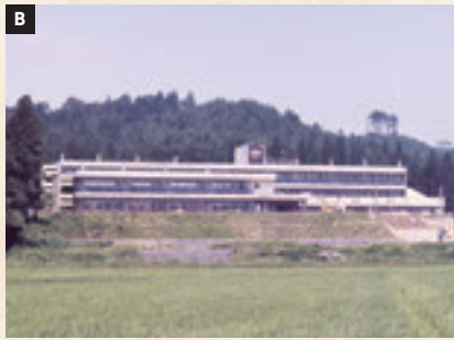
B 五城目小学校が現在地（字羽黒前26）に新築完成
