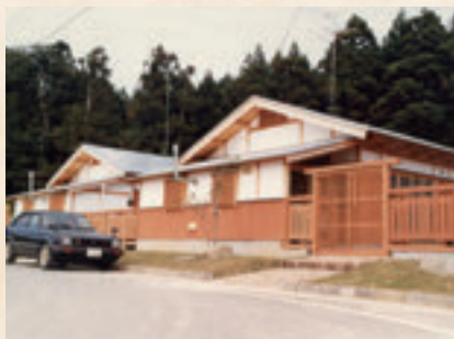
HOPE計画による公営住宅が完成
