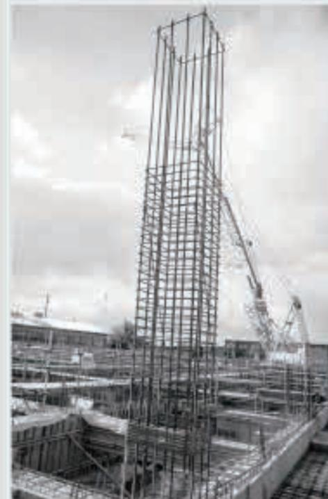
基礎杭の上に作られる柱の鉄筋。
