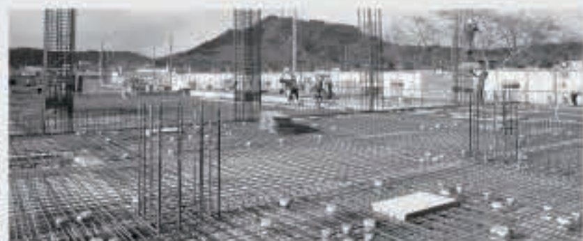
写真手前側が給食室、奥側が体育館になります。 床の配筋が完了した状態です。
