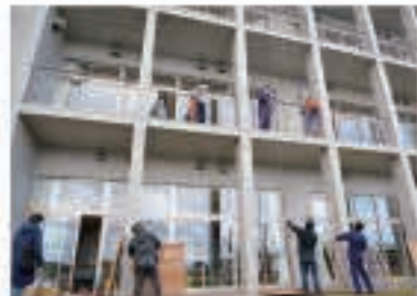
11月6日、実行委員会の皆さんが主体となって、五小校舎にイルミネーションを設置しました。
