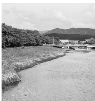
馬場目川の洲ざらい工事の様子
