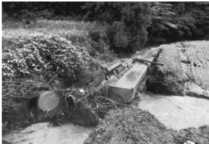
護岸崩壊した小川口川
