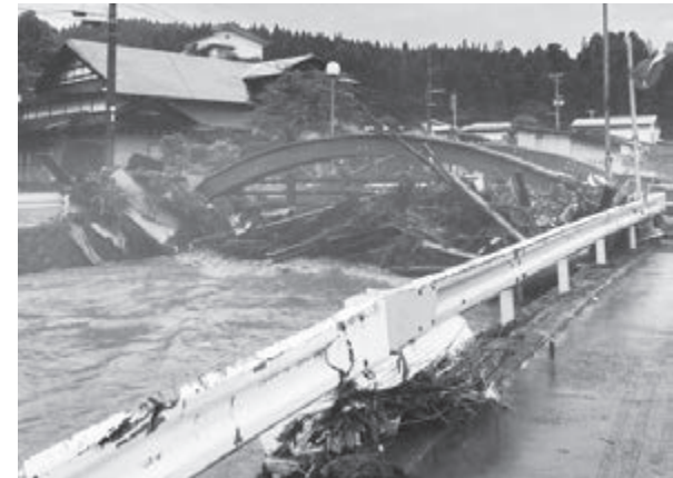
流木でふさがれた湯ノ又橋
