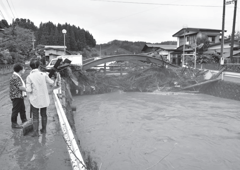
【8月12日~13日】記録的な豪雨により、内川川、富津内川の2河川が氾濫するなど、町内各地で大きな被害(写真は湯ノ又町内)。
