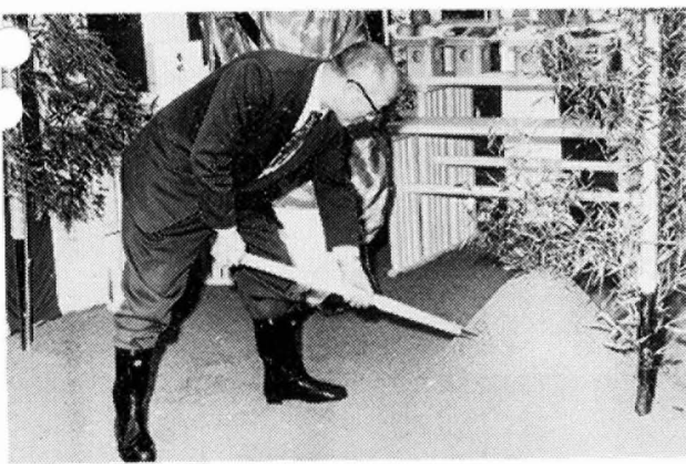
センター起工式でくわ入れをする町長
