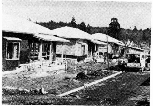
野ヶ広の台地に建設中の公営住宅
