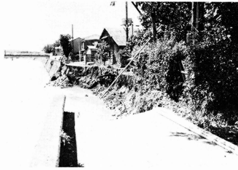
たびたびの増水で護岸も道路もけずり取られた川端線
