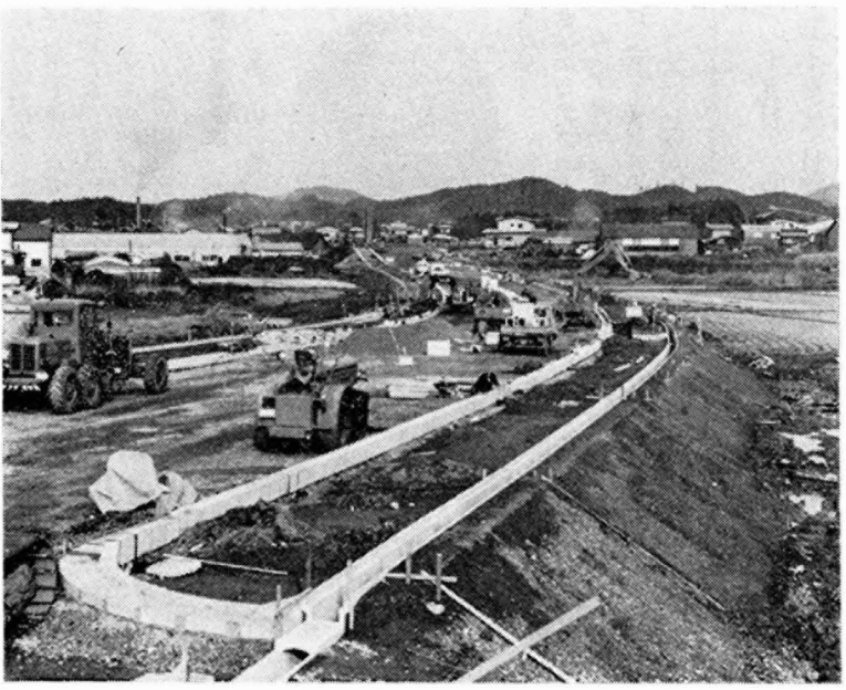
広ヶ野下山内線舗装新設完了
