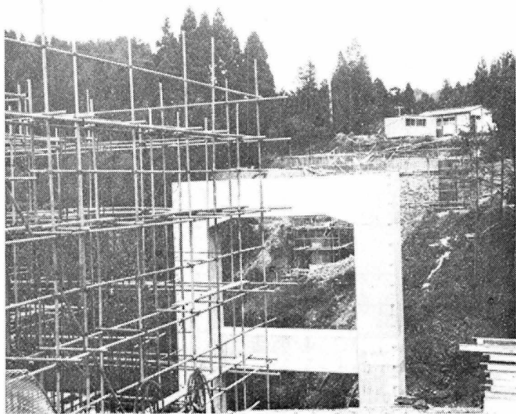
下 部 工 事 中 の 六 右 衛 門 橋 （ 60 メートル ）
