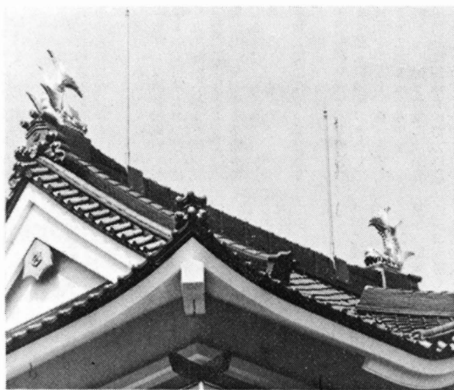
棟飾りとして取り付けられたしちほこ。
